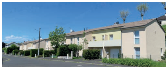
📍 Mauriac (15) : réhabilitation de 10 pavillons
